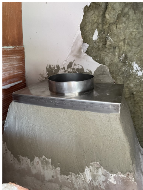
Remise en ordre de l'avaloir
